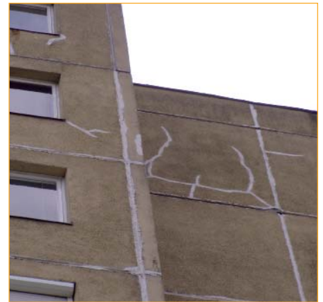
Már hőszigetelt, repedt kéreg
